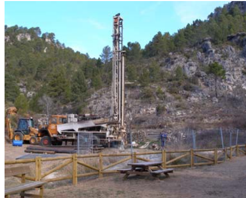
Figura 1. Situación general del Cañizares-1 Figura 2. Sondeo Cañizares-1 durante su perforación
